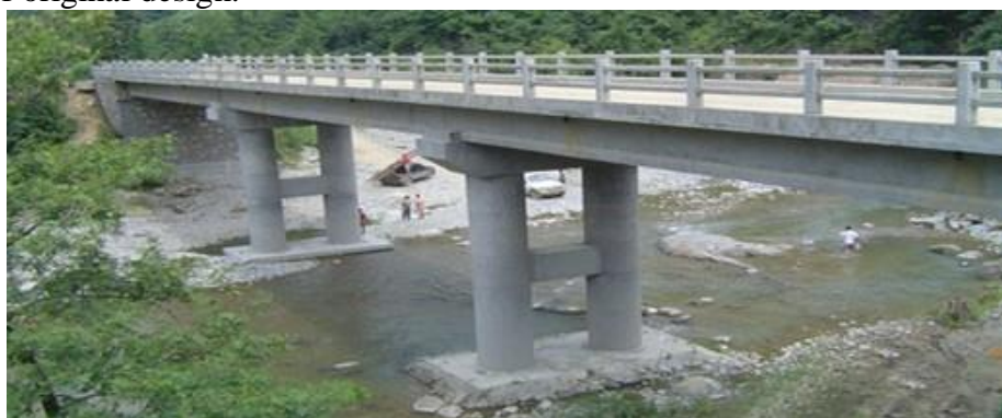
Fig. 1 Long Tan bridge
